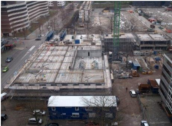
De bouw van de Fiep 2011
