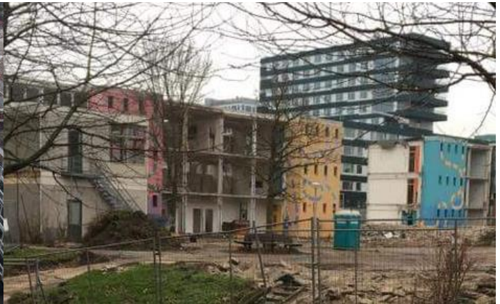
De sloop van de St. Jan de Doper 2015
